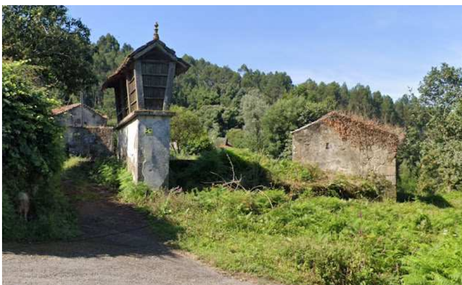
Canastro (espigueiro) e casa da eira com vista do lado norte
